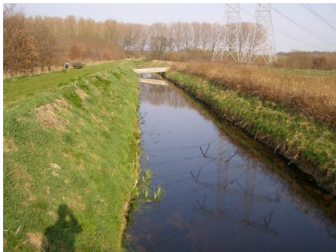
Figuur 5: Eén van de voormalige lage afwateringssloten met een betonnen kunstwerk voor de aanvoer.
